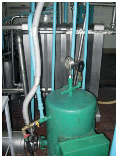
Рис. 4. Подсоединение трубопровода нагретой воды от энергозамещающего устройства к бойлеру
